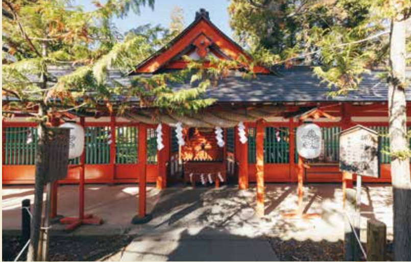
摂社 諏訪神社の本殿は、慶長15年(1610年)、上田藩主・真田信幸の寄進により再建された
